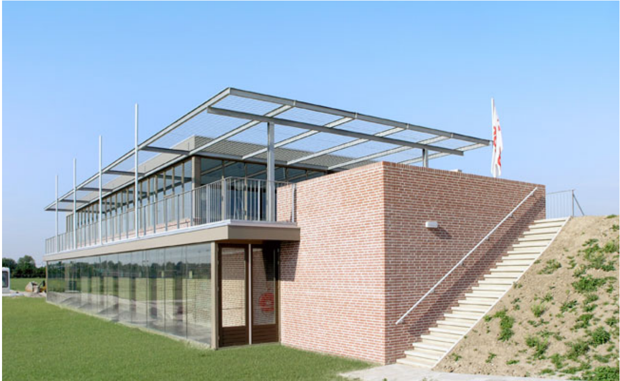
Foto: Gevel langs het hoofdveld, aansluiting op de wal.
